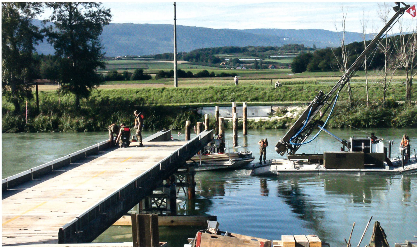
Handwerksarbeit und Truppenkönnen vom Feinsten: Bau der Stahlträgerbrücke über den Hagneck-Kanal.
