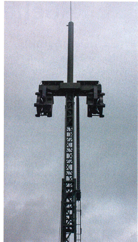
Hoch ragt der Radio Access Point auf.
