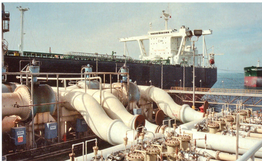
Der irakische Öl-Terminal ABOT kann gleichzeitig vier Supertanker durch gewaltige Pipelines (Durchmesser 1,22 m) mit irakischem Öl voll pumpen. In der Regel kommt alle drei Tage ein leerer Tanker längsseits.
