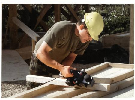
Mit ruhiger Hand werden Holzteile genau zugeschnitten.
