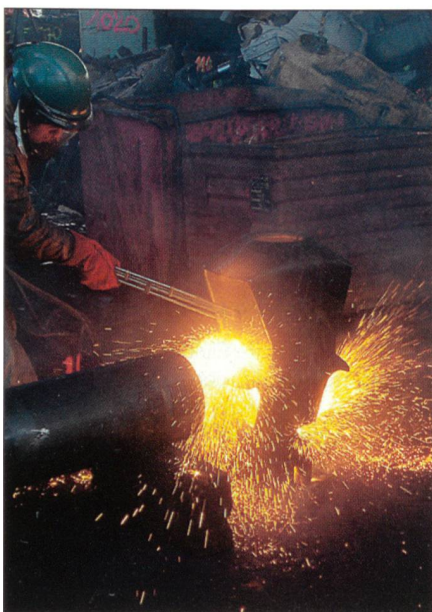
Dem Schweißbrenner widersteht auch der beste Stahl nicht.
