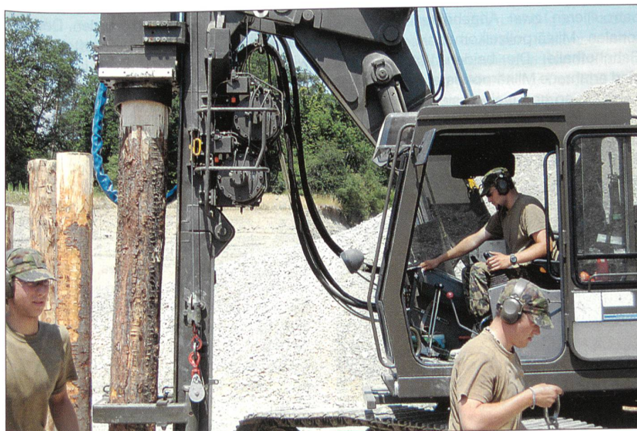
Das Geniebataillon 6 war an mehreren Brennpunkten der Übung FOXTROTT SIX im Einsatz, hier beim Rammen in einer Kiesgrube bei Marthalen im Zürcher Weinland.
