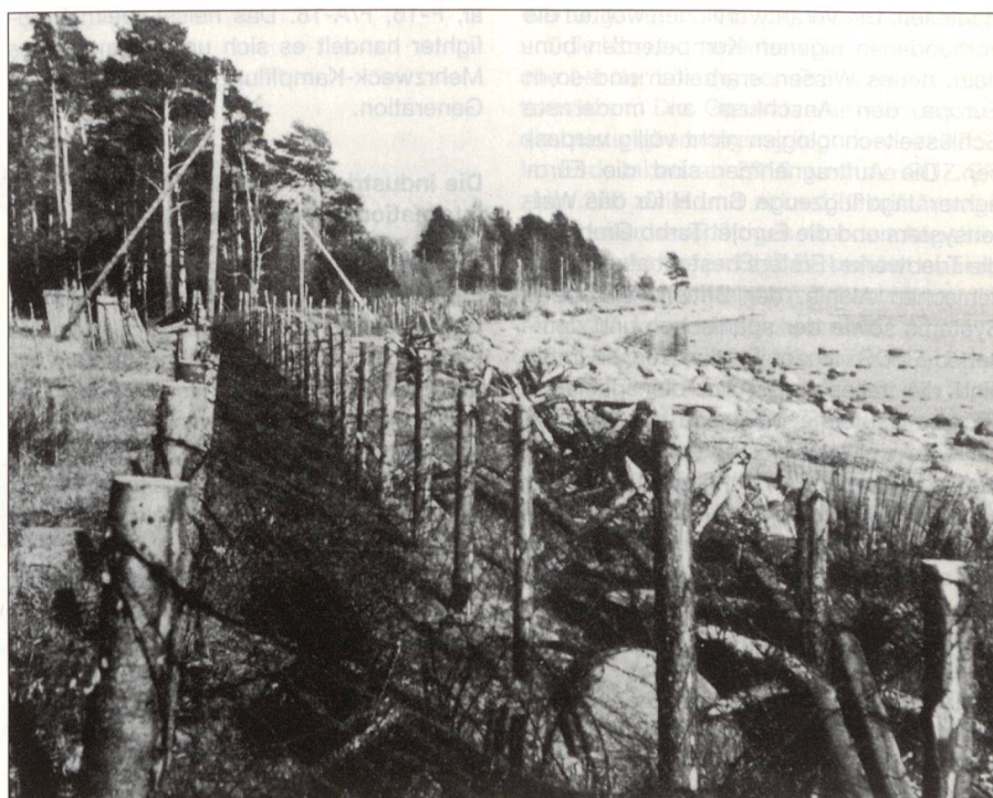
Panzerabwehrhindernis vor der Viipuri-Vuoksi-Linie im Bau.
