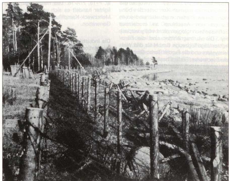
Panzerabwehrhindernis vor der Viipuri-Vuoksi-Linie im Bau.
