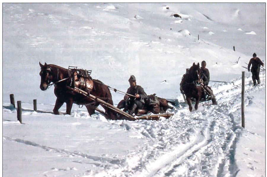
Der durch das Schauflerdetachment gebrochene und durch die Pferde gefestigte Ruttnerpfad wird anschliessend mit Schlitten trassiert, deren Kufen man quer mit einer Kette verbindet.
