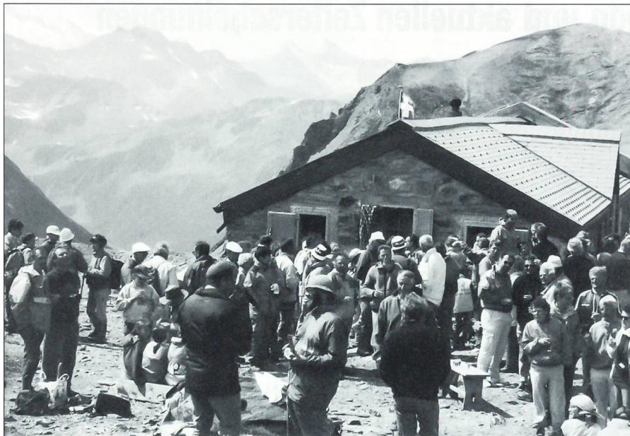
Kaltwasserhütte, 2851 m ü. M., am Kaltwasserpass Schweiz-Italien.
