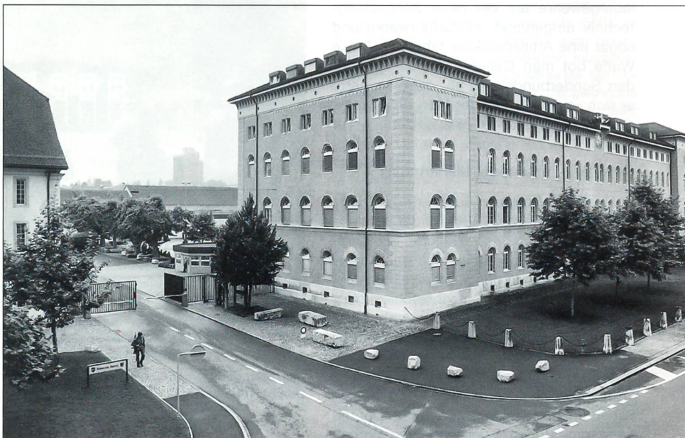
Nach langem Disput wurde die Kaserne Aarau mitten in der Stadt belassen und 1982 umgebaut. Die Fassaden des repräsentablen Gebäudes wurden in toskanischer Gotik, die auch Münchner Rundbogenstil genannt wird, belassen. (Bild Baudepartement/ZWA aus Buch «Helm auf!»)
