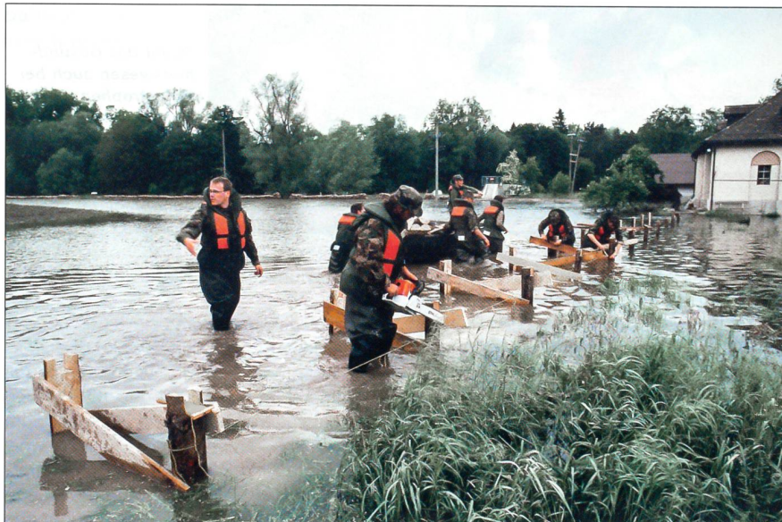
Subsidiärer Hilfseinsatz in Belp (BE), 1999: Angehörige der Rettungstruppen errichten zu den anliegenden Häusern Laufstege.
