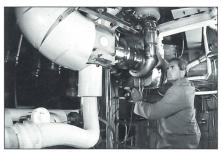
Teil des Lasers: Pumpe für das Absaugen von Hydrogen-Peroxide.
