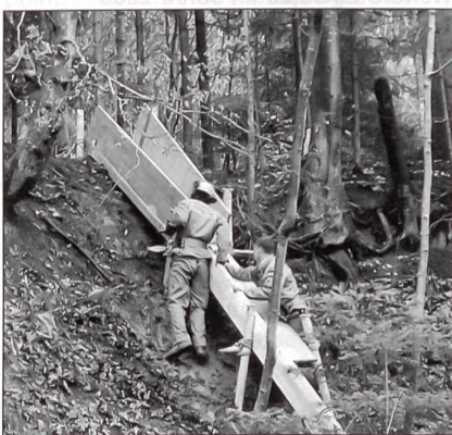
Ein Schuttkanal wird erstellt.
