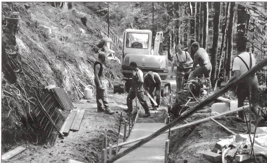
Mit dem Einbau einer Fahrrinne im steilsten Stück zur Wideregg wird das Befahren auch bei schlechtem Wetter sicherer.
