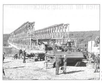
800-PS-Pionierpanzer zieht die auf Rollen gelagerte Brücke.
