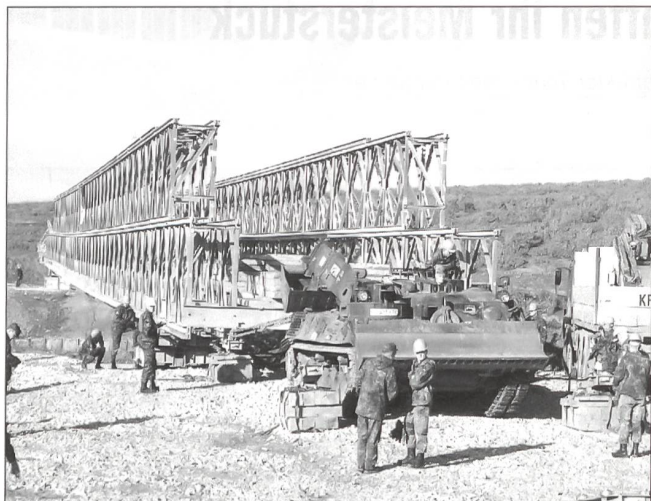
800-PS-Pionierpanzer zieht die auf Rollen gelagerte Brücke.
