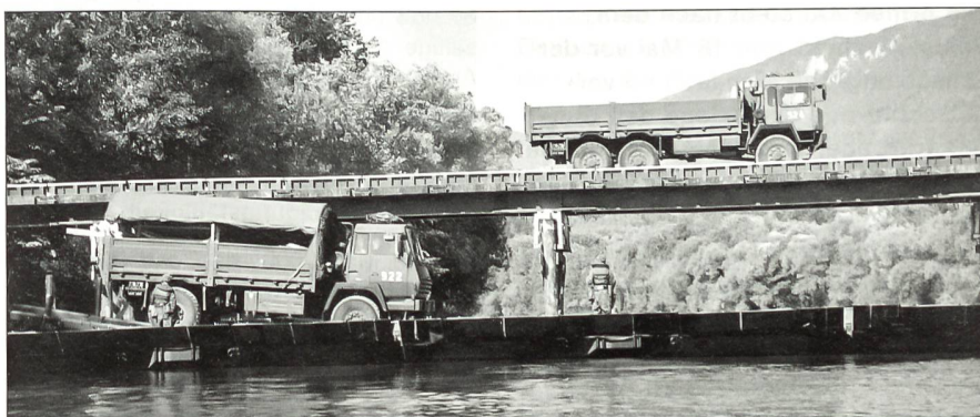
Schwere Lastwagen beim Überqueren der beiden Brücken, die vom G Rgt 2 erstellt wurden. Vorne die Schwimmbrücke 95, hinten die Stahlträgerbrücke. Beide Brücken haben die Tragkraft von 70 Tonnen. Foto: Franz Knuchel
