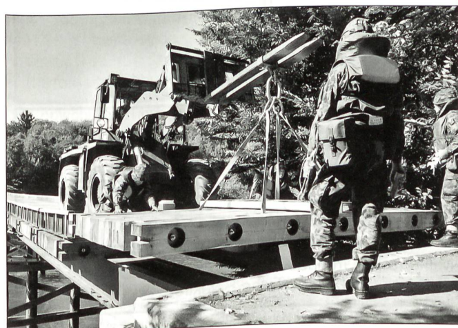
Klare Kommandos sind beim Einbau der Schwimmbrücke 95 nötig.
