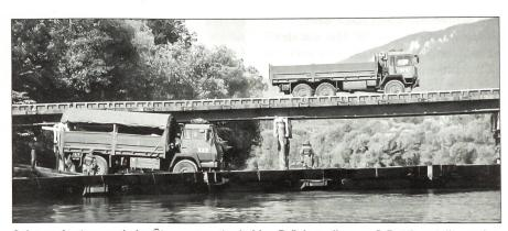
Schwere Lastwagen beim Überqueren der beiden Brücken, die vom G Rgt 2 erstellt wurden. Vorne die Schwimmbrücke 95, hinten die Stahlträgerbrücke. Beide Brücken haben die Tragkraft von 70 Tonnen.
