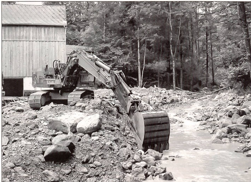
Das Bachbett des Brudererbachs wird ausgebaggert.
