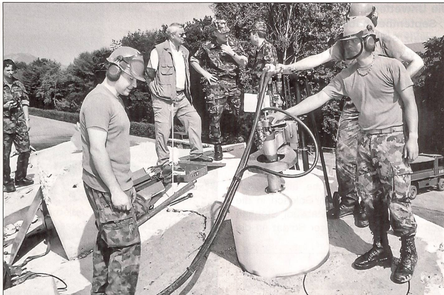
Kernbohrgerät im Einsatz, im Hintergrund beobachtet von (von links nach rechts) Oberst Martin Widmer, Major Rolf Stäuble und Oberstlt René Fischer, Kommandant des Rettungsbataillons 20.
