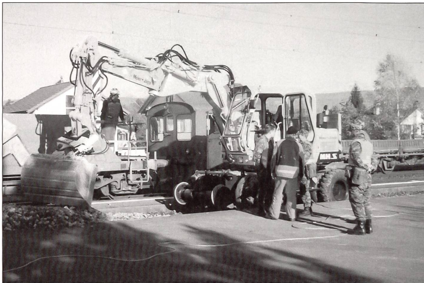
Bmfhr Martin Ettenschwiler füllt das leere «Gleis» mit Schotter aus.
