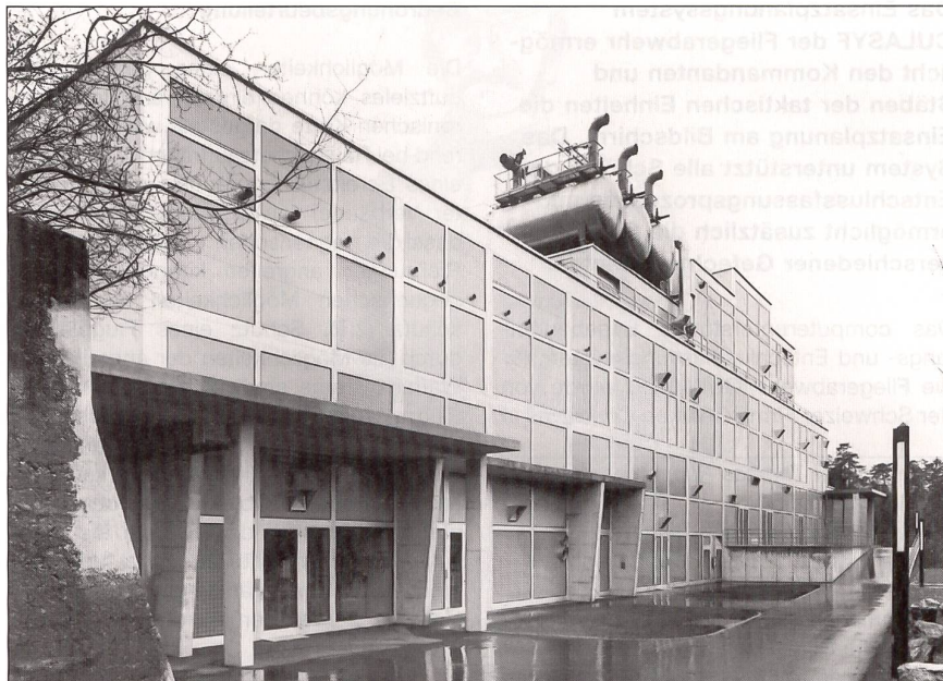
Aussenansicht Nordfassade als Ausglaswand konzipiert.
