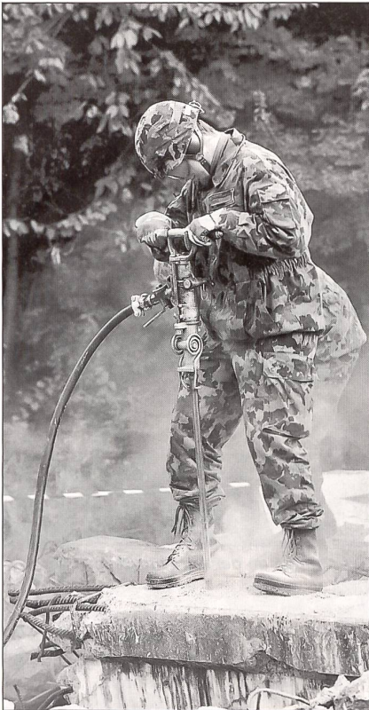
Mit Presslufthammer im Einsatz.
