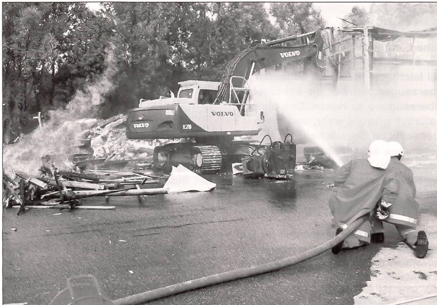
Auch die schweren Baumaschinen kamen zum Einsatz.
