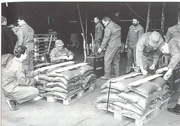
Vorsorge: Bereitstellen von Sandsäcken durch den ZS
