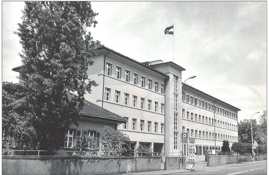
Standort AMB Zeughaus Aarau
