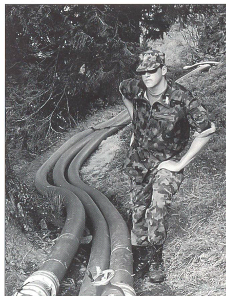
Oblt Schläpfer unterwegs bei den grossen Militärschlauchleitungen mit einem Durchmesser von 150 Millimetern und einer Durchflussmenge von gesamthaft 10 000 Litern Wasser pro Minute.
