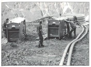
Das oberhalb der Bänzlauialp gefasste Wasser wird über die zwei Plastikrohrleitungen ins 53 000 Liter fassende Becken geleitet und dann über die vom Becken wegführenden Leitungen durch die Schwimmwasserpumpen auf die drei Kilometer lange Reise bis zum Abbruch gepumpt.
