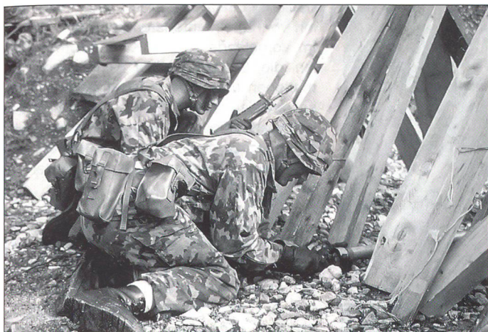
Ein Grenadiertrupp bereitet mit einem Sprengrohr die Sprengung eines Brückenkopfes vor.
