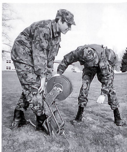
Telefonleitungsbau: Verlegen des Kabels.
