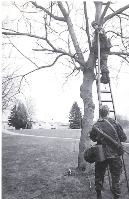
Telefonleitungsbau: Hochbau mit Linienstange.
