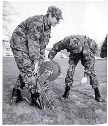
Telefonleitungsbau: Verlegen des Kabels.
