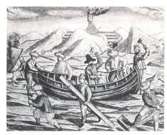
Vorbereitung zur Rückfahrt im offenen Boot: Die Wände werden aus Planken des aufgegebenen Schiffes erhöht.
