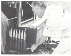
Das Revolvergeschütz 35 wird mit AHEAD-Munition beladen.
