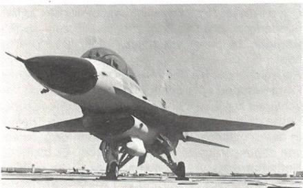
unter anderem mit einem APG-68-Radar, ALR-56M-Radarwarnempfänger, einem wesentlich modifizierten ALE-47 Chaff/Flare System ausgerüstet. Ausserdem stehen der Block-50-Version verbesserte Möglichkeiten, die Anti-Radar-Lenkwarfen vom Typ HARM (High Speed Anti Radiation Missile) einzusetzen, zur Verfügung.
