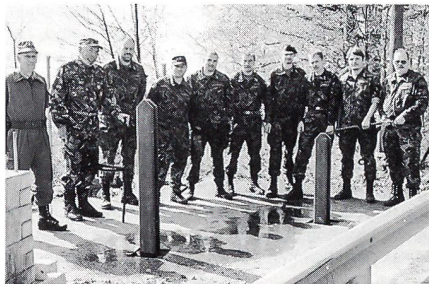
Die Mitglieder des UOV Baselland beim Einbau eines Panzerhindernisses unter Anleitung eines Festungswächters.
