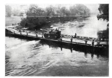
Fertig eingebaute Schwimmbrücke 95.
