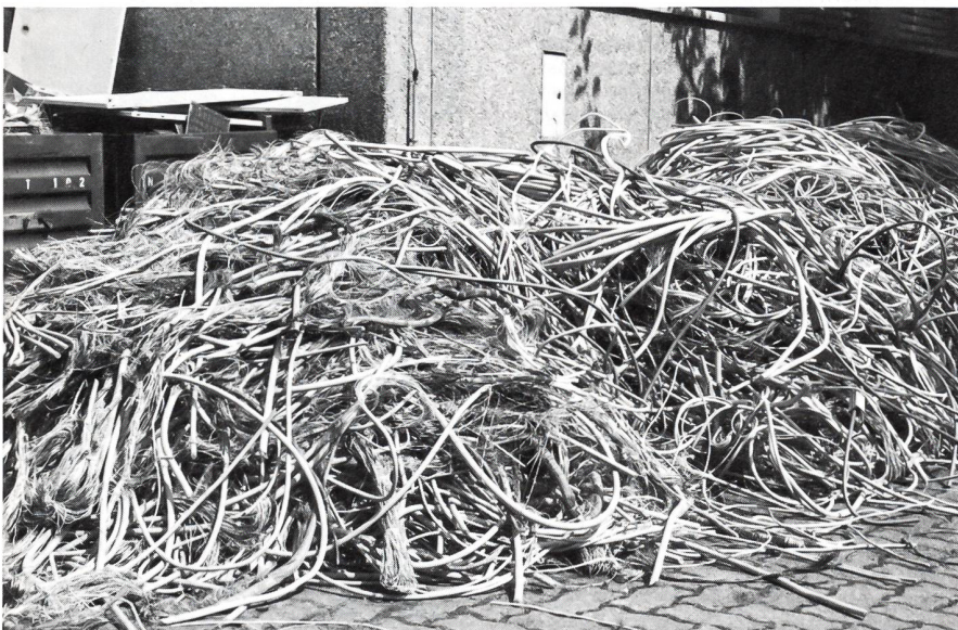
Unzählige Kilometer Telefonkabel sind in der elektromechanisch gesteuerten Fernmelde-Zentrale Breitenbach (SO) überflüssig geworden. Ein Detachment der TT-Betr Kp 21 ad hoc hat sie ausgebaut.
