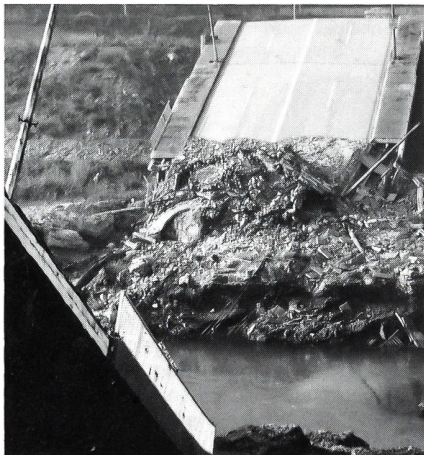
Zerstörte Brücke zwischen Ost- und West-Mostar.
