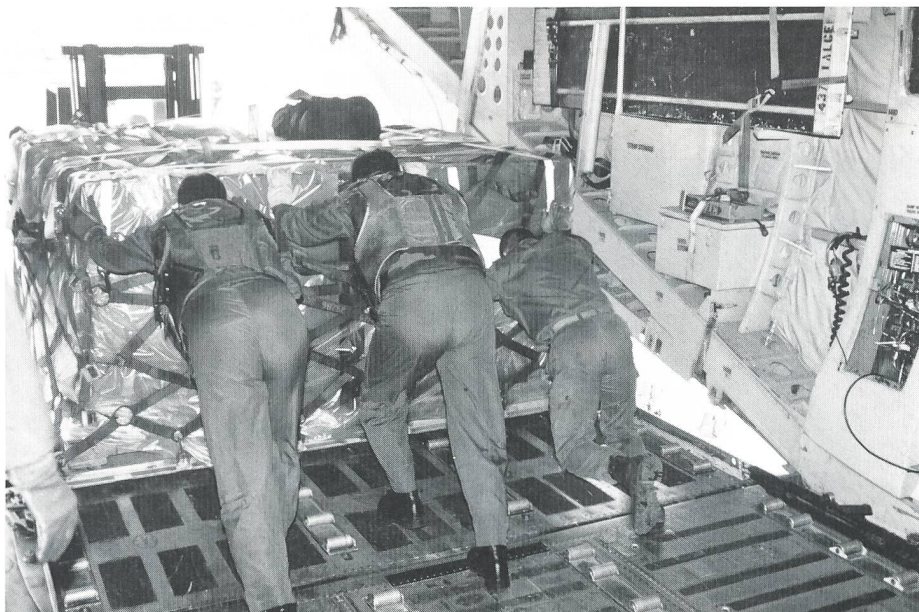
Die Paletten müssen von Hand aus dem Flugzeug gestossen werden. Schwerarbeit für die Crew.
