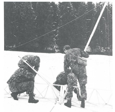
Die HF-Antenne «Granger 747» wird aufgestellt. Frequenzbereich 4 bis 30 MHz.
