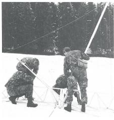
Die HF-Antenne «Granger 747» wird aufgestellt. Frequenzbereich 4 bis 30 MHz.
