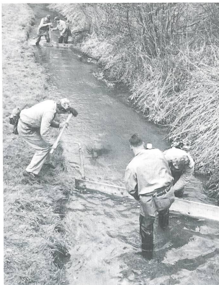
Errichten einer improvisierten Öl-Bachsperrre
