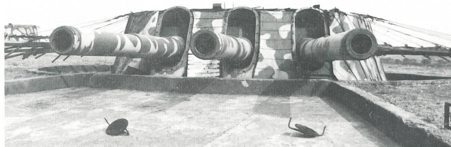
Eines der beiden 30,5-cm-Drillingsgeschütztürme der Batterie «Maxim Gorki I». Diese Türme wurden Anfang der 50er Jahre eingebaut.
