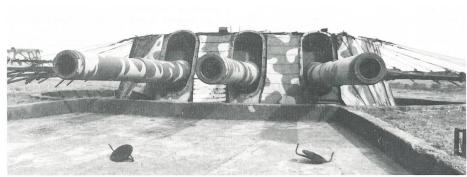
Eines der beiden 30,5-cm-Drillingsgeschütztürme der Batterie «Maxim Gorki I». Diese Türme wurden Anfang der 50er Jahre eingebaut.
