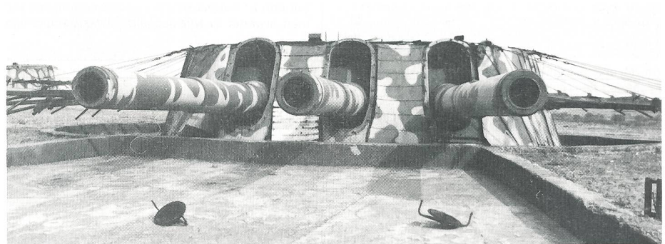
Eines der beiden 30,5-cm-Drillinggeschütztürme der Batterie «Maxim Gorki I». Diese Türme wurden Anfang der 50er Jahre eingebaut.
