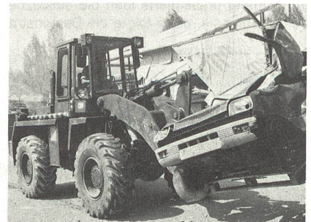
Baumaschinen werden eingesetzt, um den Weg freizuräumen.
