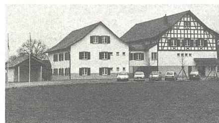
Werkhaus Oberstammheim am südwestlichen Dorfrand – rechts Altbau, links und Mitte Erweiterung
