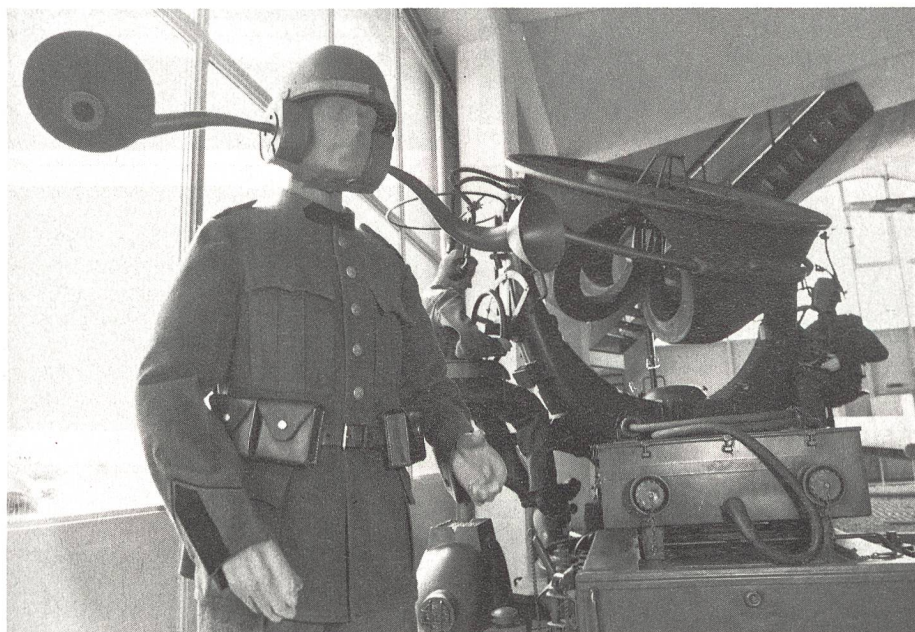
Horchposten mit «verlängerten Ohren». Solche Hörrohre wurden Ende der dreissiger Jahre versuchsweise eingesetzt. Im Hintergrund ein Siemens-Horchgerät «Elascop» aus dem Jahre 1936.
