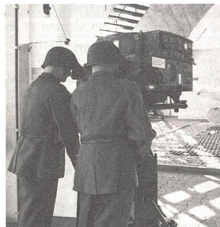
Handbedientes Flab-Kommandogerät, sogenannte Geschützvorhalterechner der Firma Gama Ungarn für die 7,5-cm-Flab-Geschütze.
