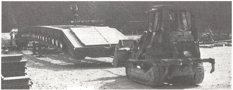
Einbau einer Festen Brücke
