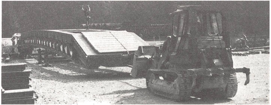
Einbau einer Festen Brücke
