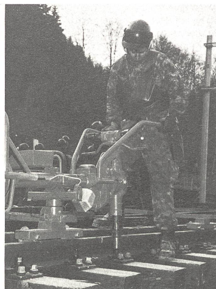
Eisenbahnsappeur-Rekrut beim Training mit der Schwellen-Laschenschraubmaschine
