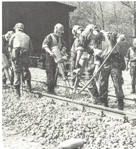
Ein neues Geleise wird eingebaut und geschottert. Ein moderner Gehörschutz gehört dazu. Diese Arbeit ist sehr lärmintensiv.
