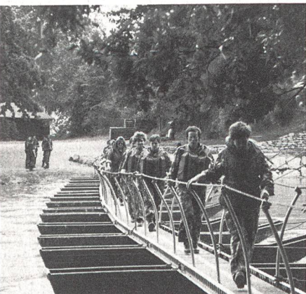
Angehörige MFD-Kader bei der Arbeit beim Erstellen eines Steg 58 über die Reuss
