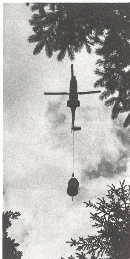
Transportheli der Armee «SUPER PUMA» mit grossem Betonschacht für das Reservoir.
