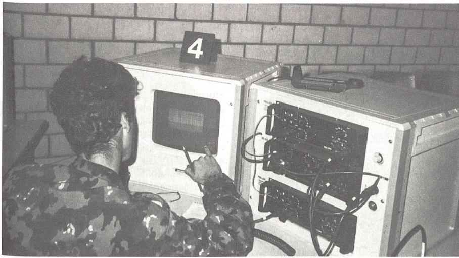
Der Soldat kann durch Drücken einer Taste ablesen, ob sein Funkspruch über den Simulator richtig angekommen ist.
