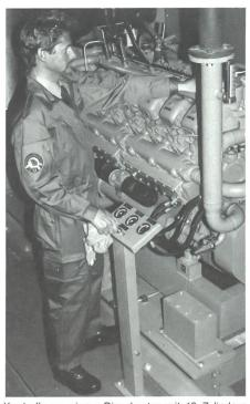
Kontrolle an einem Dieselmotor mit 12 Zylindern (210 kW) für eine Notstromgruppe einer Festungsanlage, Festungswächter in neuer Uniform.
