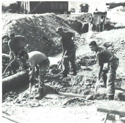
Aspiranten der Luftschutz-OS beim knochenharten Arbeitseinsatz im Bergsturzgebiet bei Randa.
