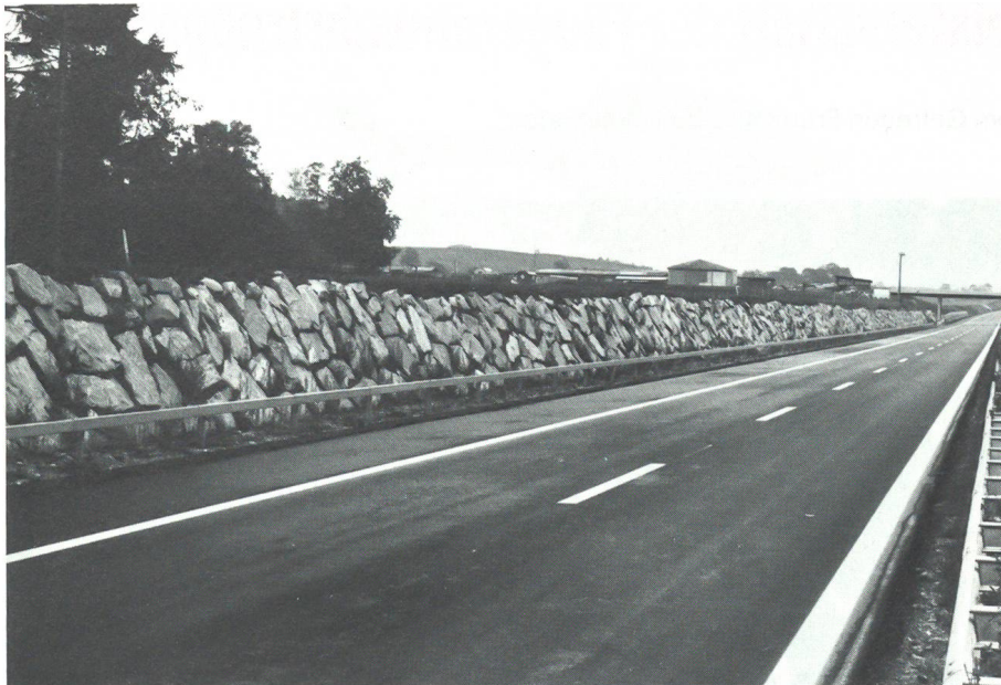
Panzerhindernisböschungen verhindern das Ausbrechen eines Gegners ins Gelände.
