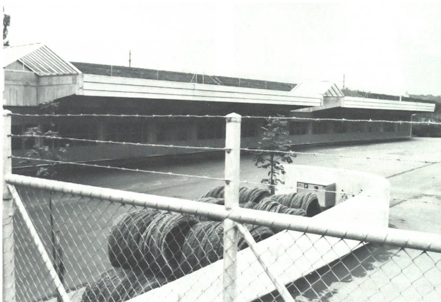
Das erste Zeughaus unter einer Autobahn wurde bei Müllheim gebaut.
