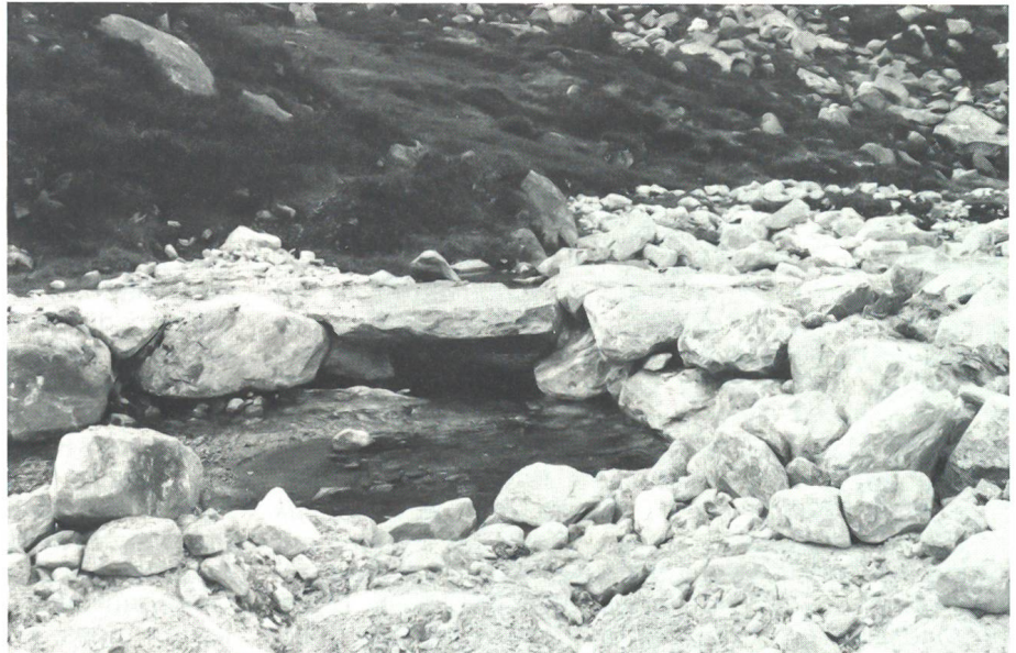
Der alte Wanderweg über den Gotthardpass. Genisten der Seilb Kp III/23 bauten diese Steinbrücke handwerk-mässig ohne Zement.
