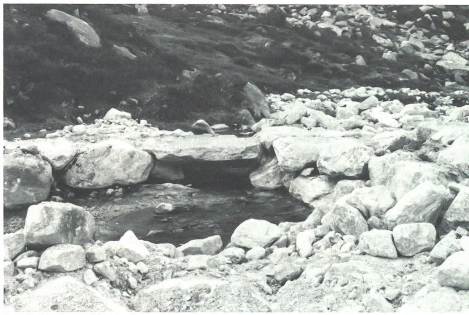
Der alte Wanderweg über den Gotthardpass. Genisten der Seilb Kp III/23 bauten diese Steinbrücke handwerk-mässig ohne Zement.
