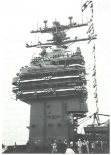
Der Kommandoturm, auch «Insel» genannt, des Flugzeugträgers «USS George Washington» ist seitlich am Flugdeck rechts (steuerbord) plaziert. Er umfasst 8 Decks. Das 5. Deck (der sogenannte 07 level, als untere Fensterreihe erkennbar) ist die Admiralsbrücke, das 6. Deck ist die eigentliche Brücke, auch Navigationsdeck genannt, von welchem aus der Kapitän sein Schiff führt. Zuoberst befindet sich der «Kontrollturm», von wo aus der Flugverkehr auf dem Deck geführt wird.
