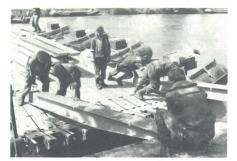
Baupontoniere beim Montieren der Rampenelemente am gegenüberliegenden Flussufer.
