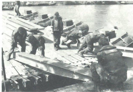
Baupontoniere beim Montieren der Rampenelemente am gegenüberliegenden Flußufer.
