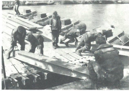
Baupontoniere beim Montieren der Rampenelemente am gegenüberliegenden Flussufer.
